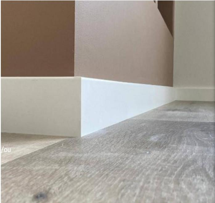
Rodapé fabricado em PVC expandido atóxico antichoque revestido com película decorativa. Pode ser aplicado com a utilização de colas adequadas do tipo MS Polímero.
